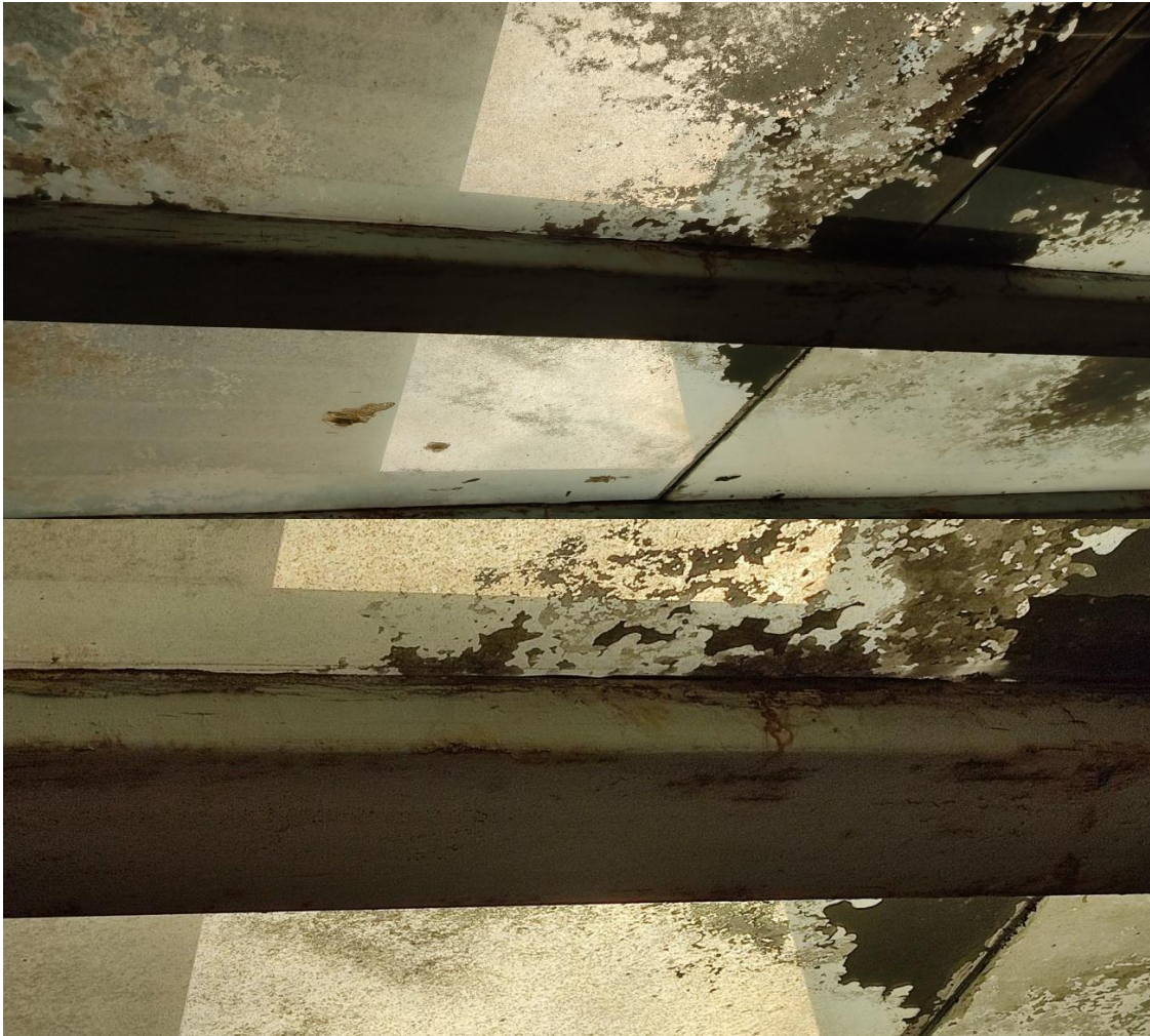
Figura 18: Detalhe da viga de subestação dos vidros com corrosão.
