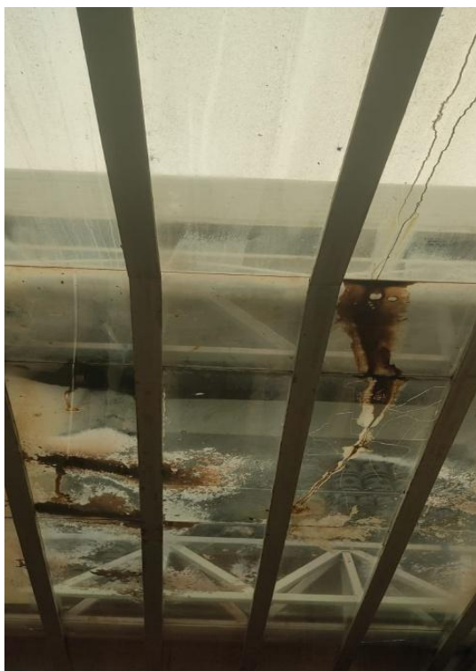
Figura 02: Vidros com espessa carbonatação.
