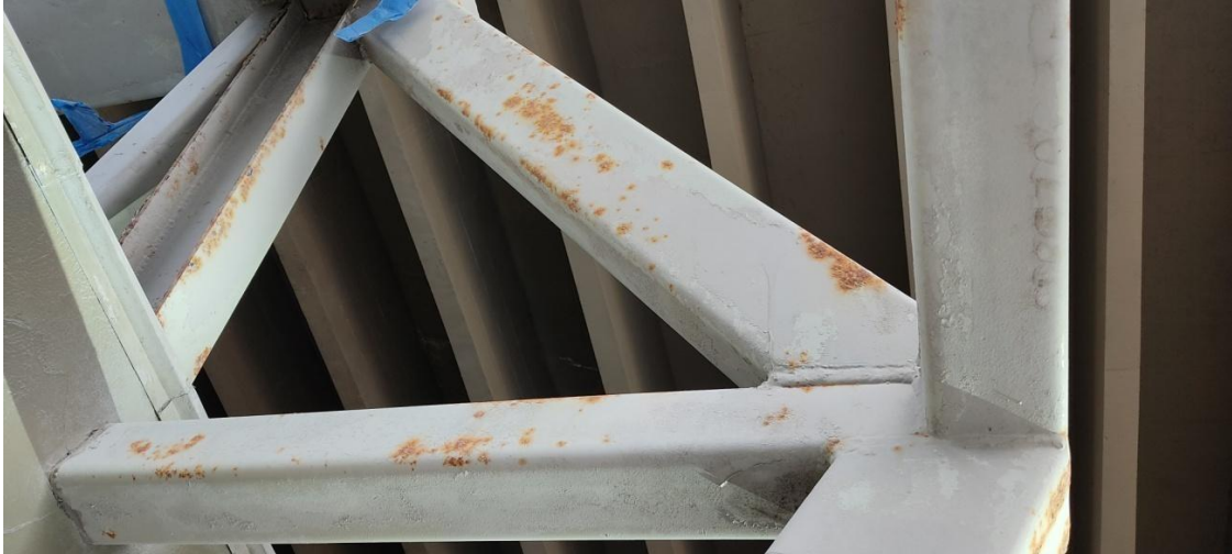
Figura 10: Detalhe da corrosão.
