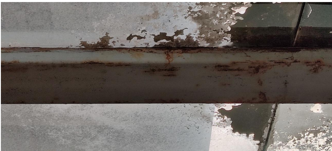
Figura 18: Detalhe da viga de subestação dos vidros com corrosão.
