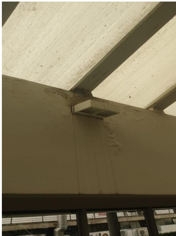
Figura 04: Manchas de água formando poças de goteiras na cobertura.
