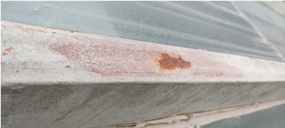
Figura 08: Detalhe da corrosão nas vigas de subestação dos vidros.
