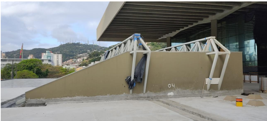
Figura 11: Vista lateral da cobertura.
