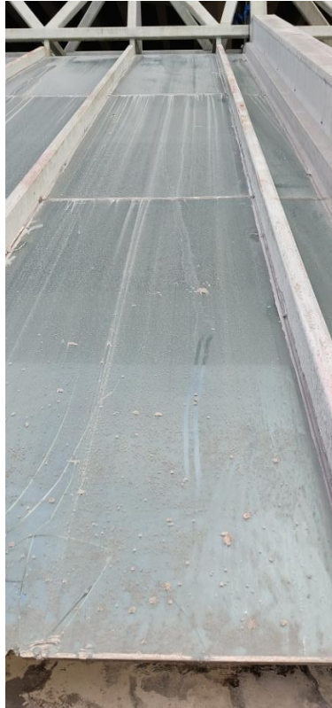
Figura 08: Detalhe da corrosão nas vigas de subestação dos vidros.
