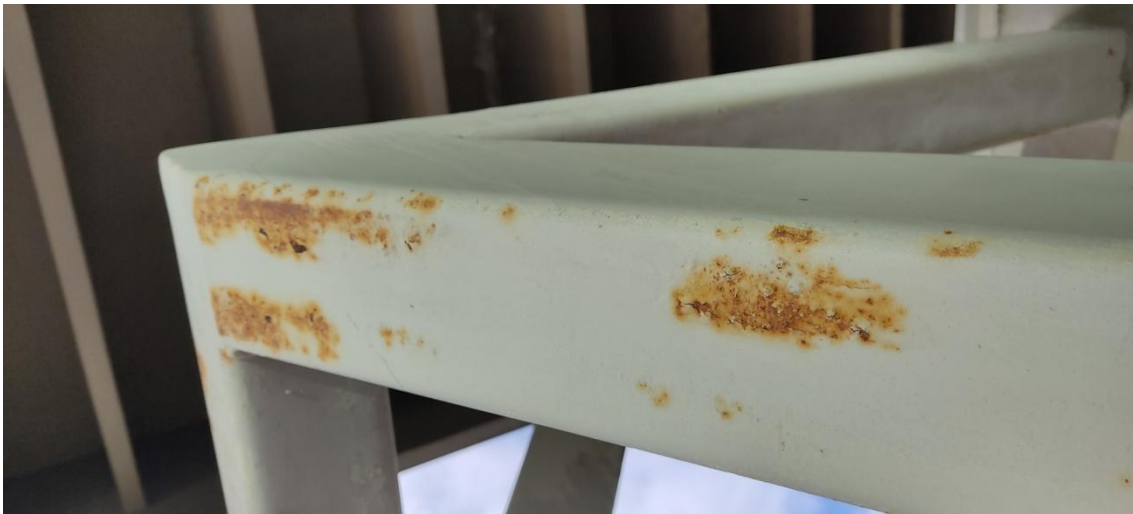
Figura 10: Detalhe da corrosão.
