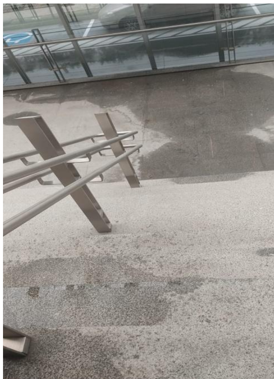
Figura 04: Manchas de água formando poças de goteiras na cobertura.
