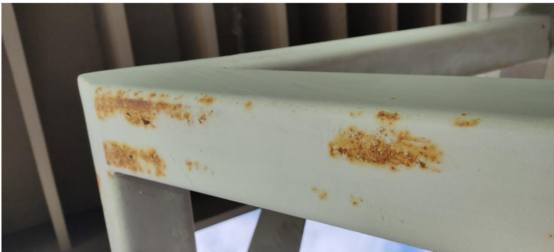
Figura 10: Detalhe da corrosão.
